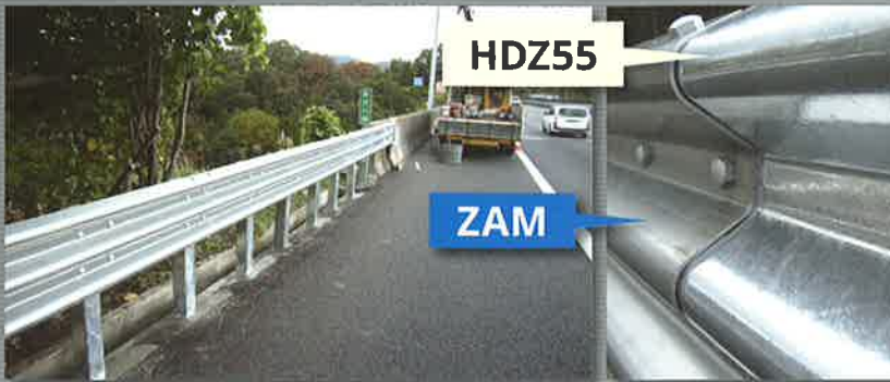
モニター施工風景 (東名自動車道藤沢川橋付近)
